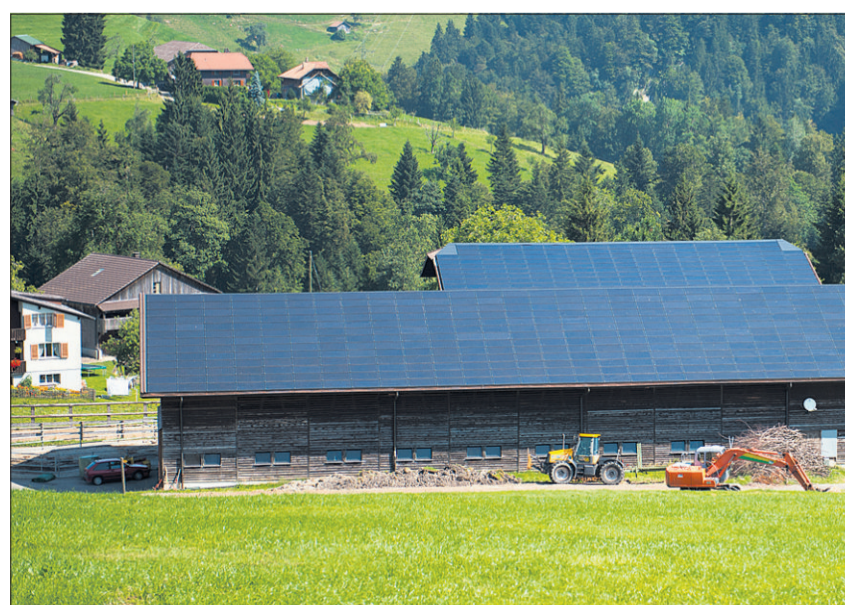
Die Photovoltaikanlage Mittler Rotmoos trägt zur Stromproduktion der Region bei.
